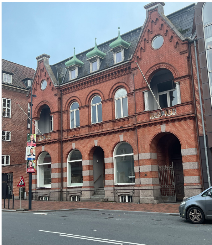
Den første nationalbank-bygning i Kolding er et meget bevaringsværdigt historicisme-hus. Ejeren vil gerne indrette en bolig i tagetagen, men de smukke løgkupler med de små vinduer nedenunder er svært forenelige med kravene i byggelovgivningen.
