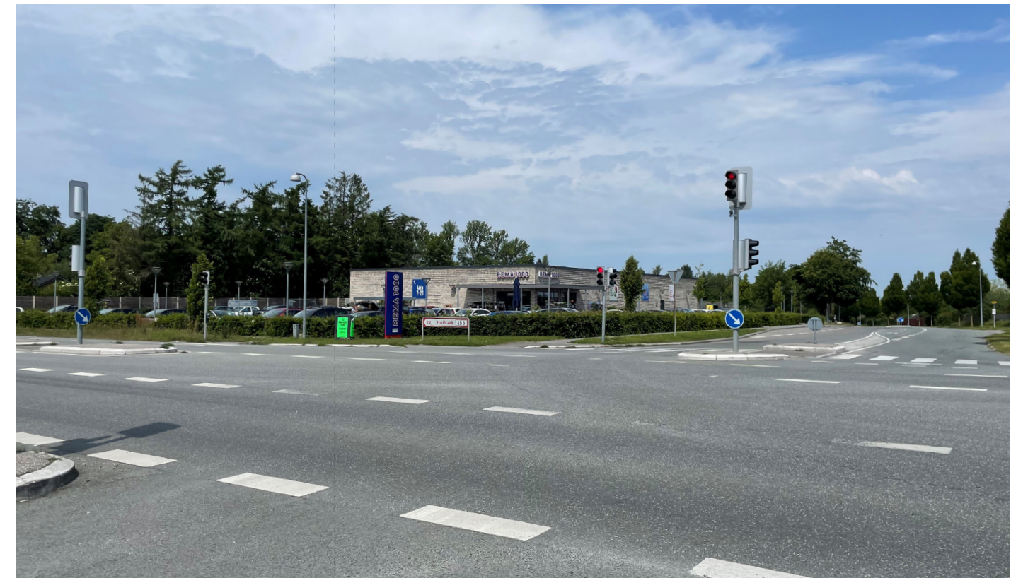
REMA 1000 i Gevninge. FOTO: JAKOB HØJ, ARTELIA
