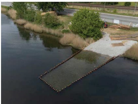
Anlæg af testanlæg til Membranen, Tirsbæk Strandvej, maj 2025. FOTO: VEJLE KOMMUNE
