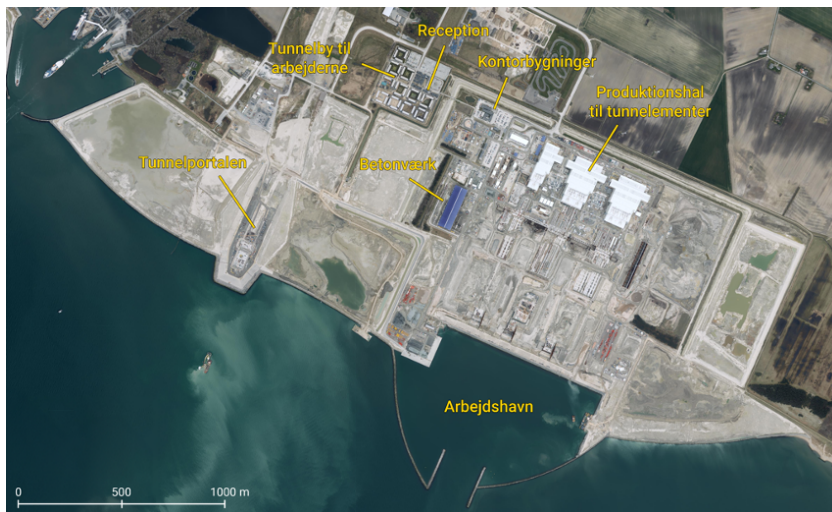
Foto 2. Oversigt over byggepladsen til Femern Bælt tunnelen i foråret 2023.
