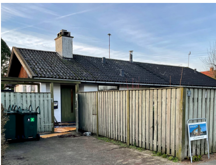
Gasbetonhus til nedrivning
