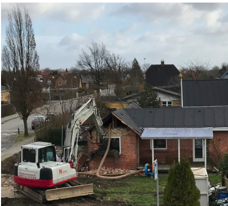
Nedrivningsprocessen i gang
