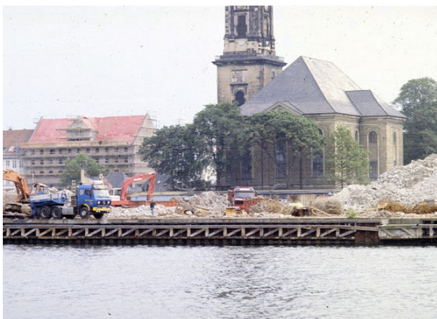
B &W under nedrivningerne. Foto: Karsten Jørgensen
