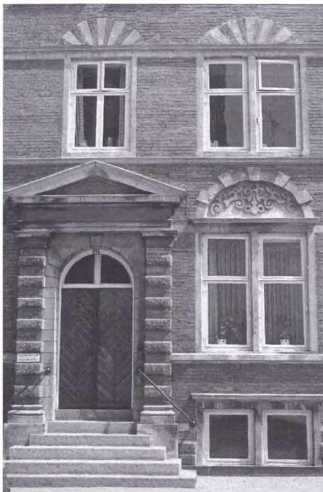
Sparekassen, Hillerød, opført 1873. Foto 1986 (V.D.)
