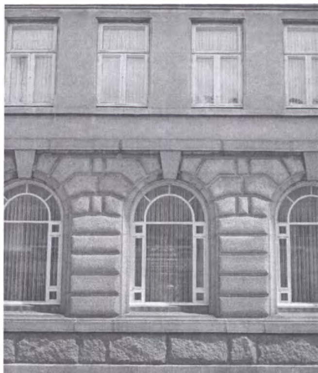
Sparekassen, Hillerød, opført 1900. Foto 1986 (V.D.)
