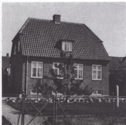
Bedre Byggeskik, 1920-erne.
