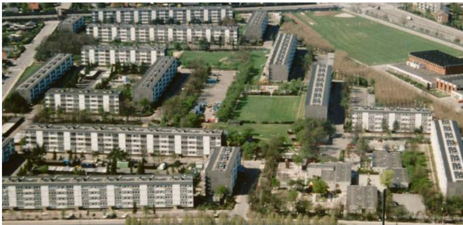
Ill. 6. 'Friheden med sine 1.170 boliger, hvor den stereotype bebyggelsesplan viser nogle uhensigtsmæssige bindinger dikteret af montagens kranspor og en udbredt mekanisk repetition.' (KAB 2008)
