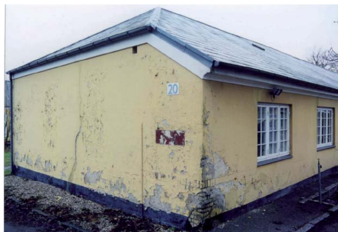
Figur 7. Belægningsbygning ved forsvarets flytning
