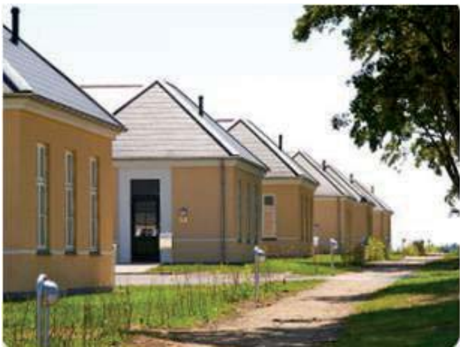
Figur 8. Belægningsbygninger efter udvendig efterisolering
