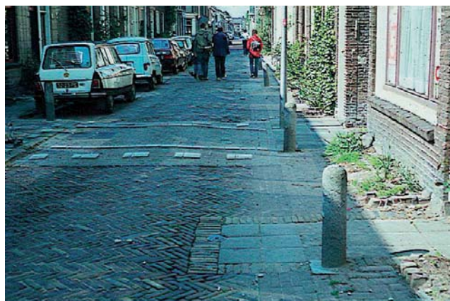
Westerkwartier i Delft. Gadens omlægning fra den normale tværprofil med forsænket køreareal og hævede fortove til et gennemgående fortovsareal hvor bilerne tillades, er ideen bag woonerf og trafikintegration.
