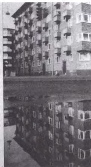
I denne ejendom på Østerbro skal spildevandet fra bad og håndvask genbruges til skyl WC'erne.
