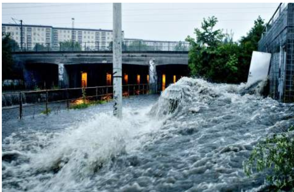
Oversvømminger ved Ryparken Station efter skybrud
