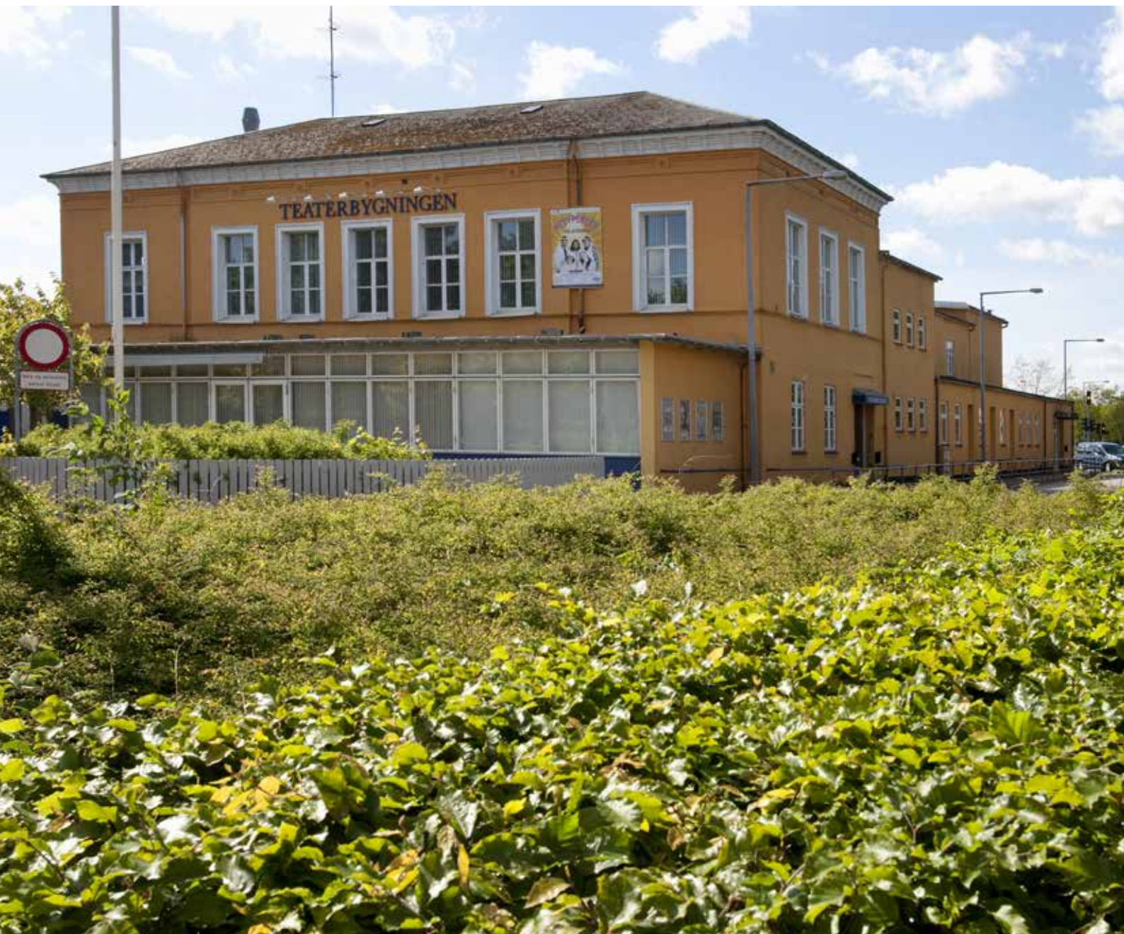
Teaterbygningens villa inden nedrivning af tilbygning.
