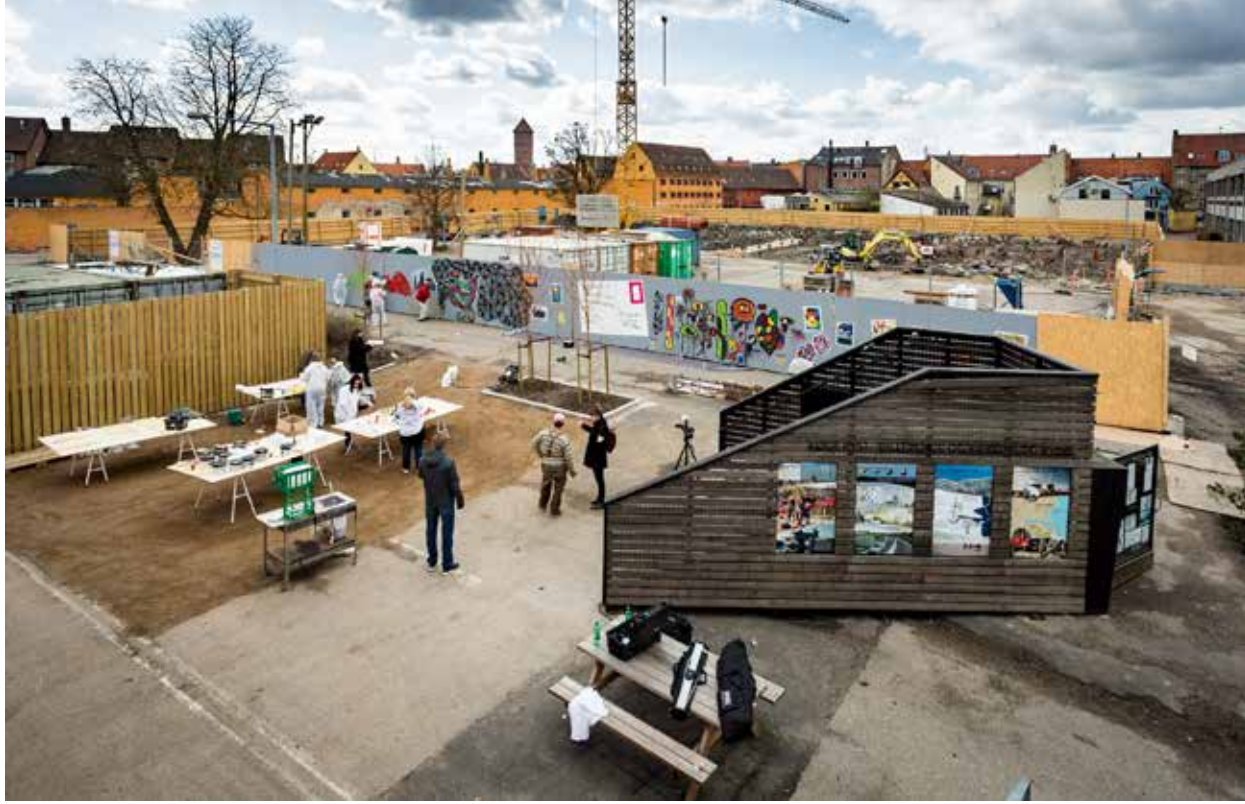
Køge Maler – work in progress.
