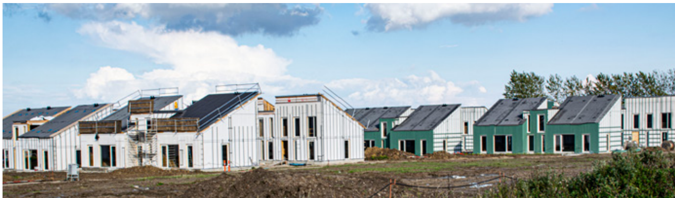
Karise Permatopia i byggefasen
