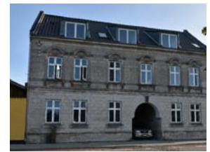
Førfoto af Havnegade 27. FOTO: DAN-PROJECT
