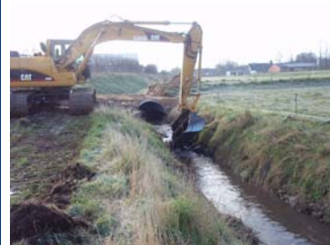
Anlæg af gydebanke og bro Smedebækken v. Tværvej.
