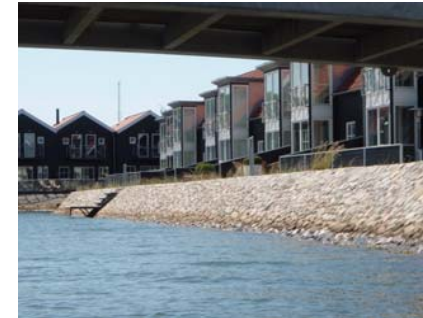
Små havneindløb og havudsigt gør "de sorte huse" til attraktive ferieboliger. De vil være ekstremt vanskelige at beskytte
